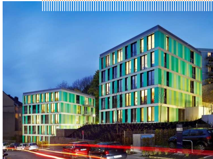
Bild 4: Preisgekrönt: Der Neubau des Studentenwohnheims „Im Ostersiepen 9 -11“ in Passivbauweise wurde mit dem Deutschen Bauherrenpreis ausgezeichnet. © HSW/Sigurd Steinprinz
